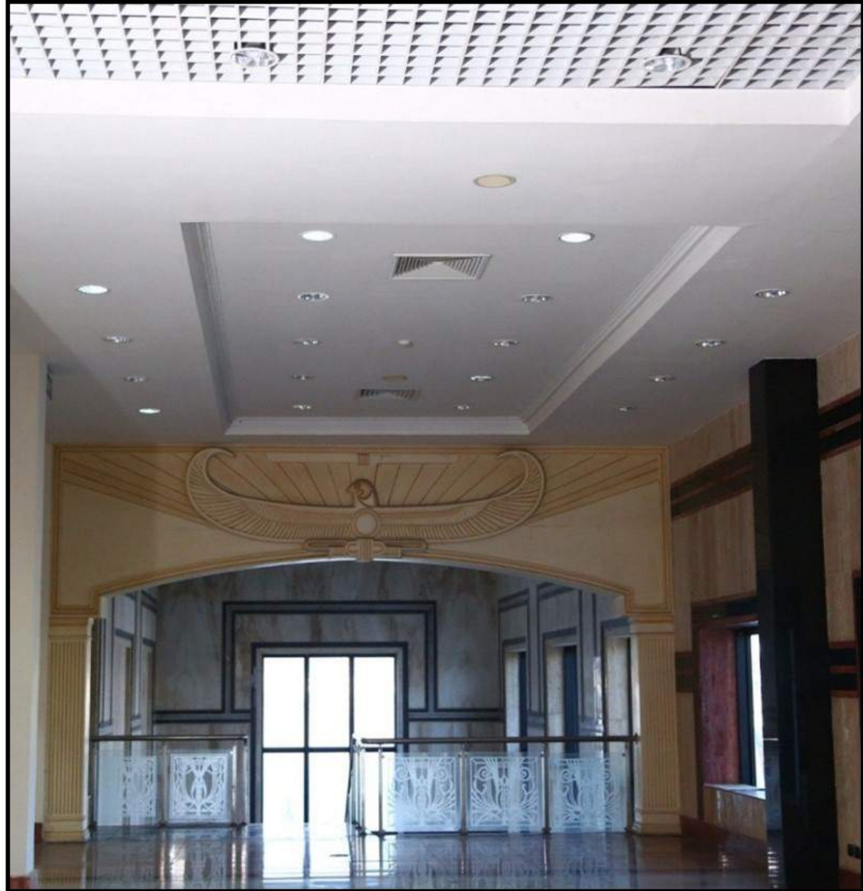
مخارج التكييف وانذار الحريق واطفاء الحريق ( A )
