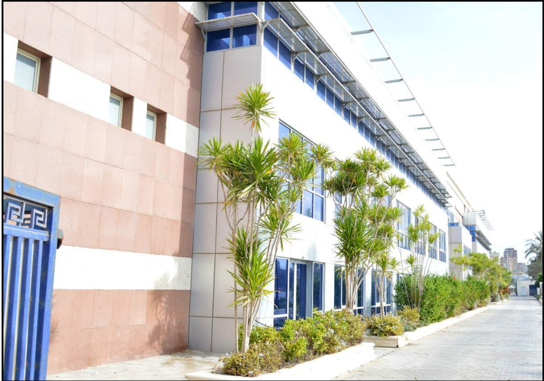
الواجهة الجانبية للمركز التجاري
